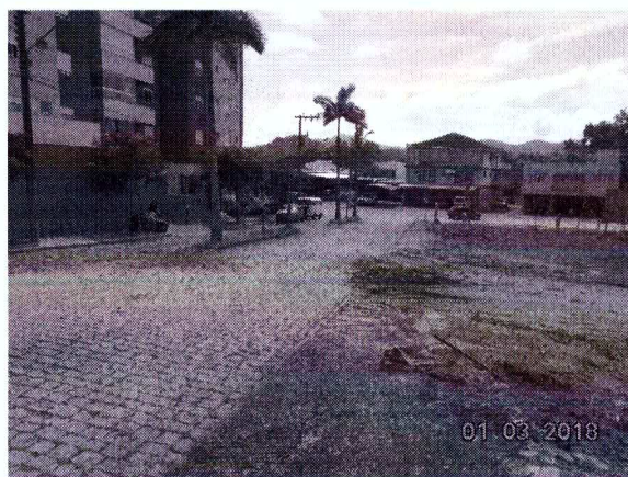
Fotos da pavimentação da rua Rio de Janeiro após a passagem dos caminhões.
