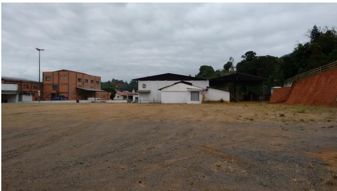
Figura 38 – Local de implantação da edificação – vista de quem olha da rua Blumenau para o terreno, ao fundo Frigorífico.
