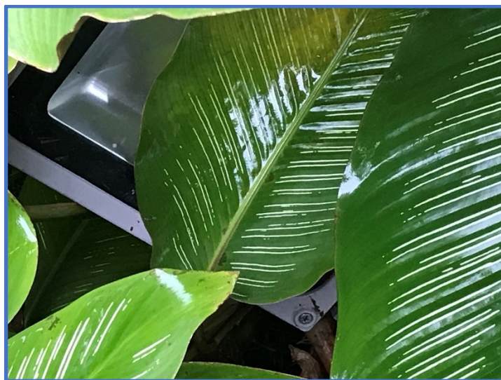
Fig. 12 – Fluxo luminoso obstruído por vegetação – Praça da Tapyoka
