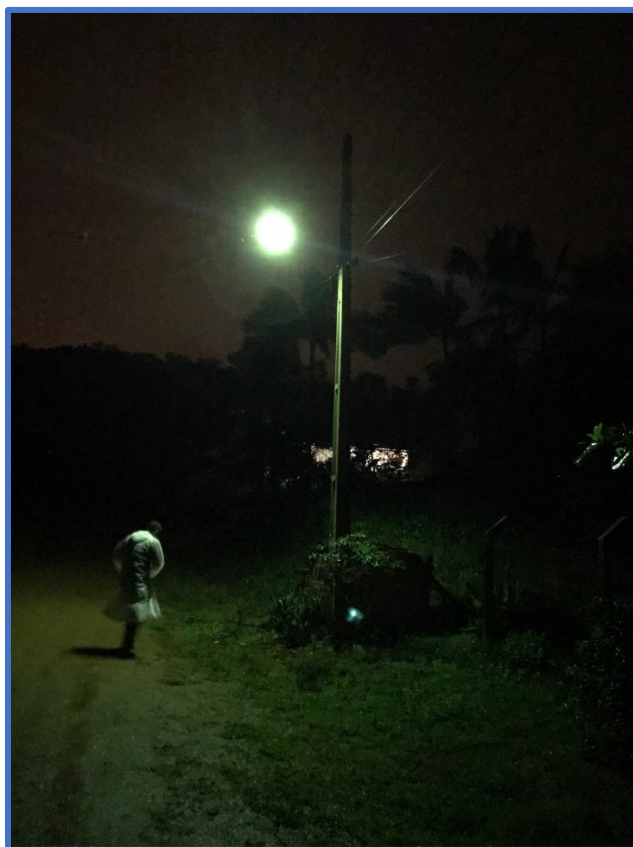
Fig. 15 – Iluminação com lâmpada a vapor de mercúrio (80W) – Rua Santos
