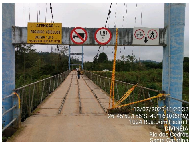
Figura 2 - Tabuleiro da ponte em peças pré-moldadas de concreto armado
