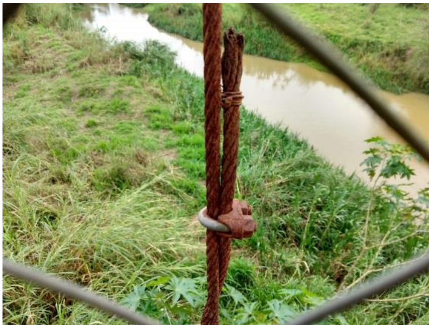
Figura 6 - Pendural de aço e fixadores com oxidação
