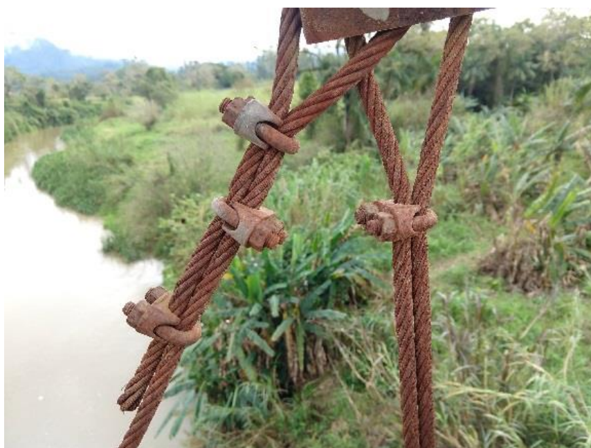
Figura 5 - Pendurais de aço e fixadores com oxidação
