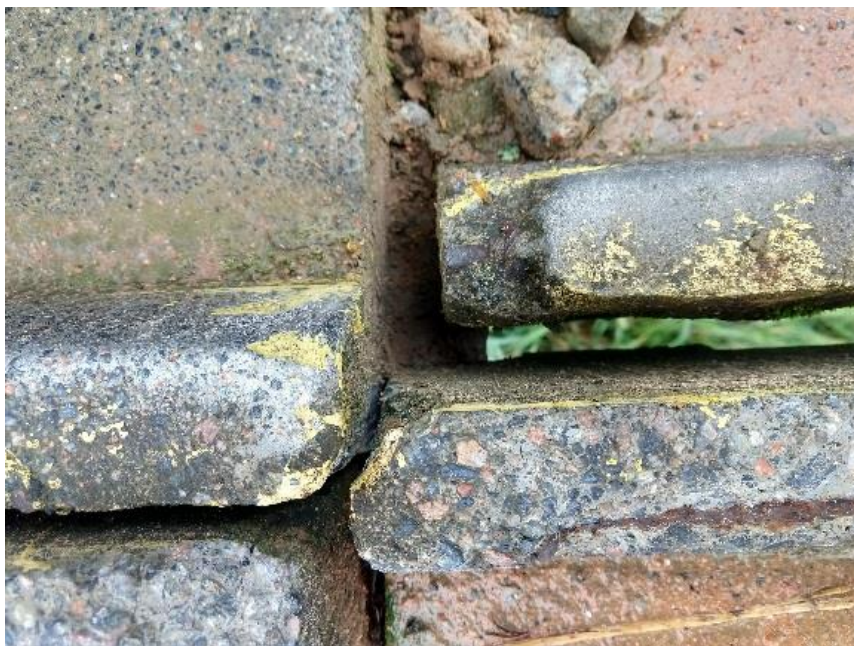
Figura 13 - Deslocamento transversal e longitudinal das peças pré-moldadas
