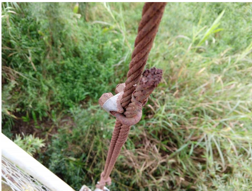
Figura 7 - Pendural de aço e fixadores com oxidação
