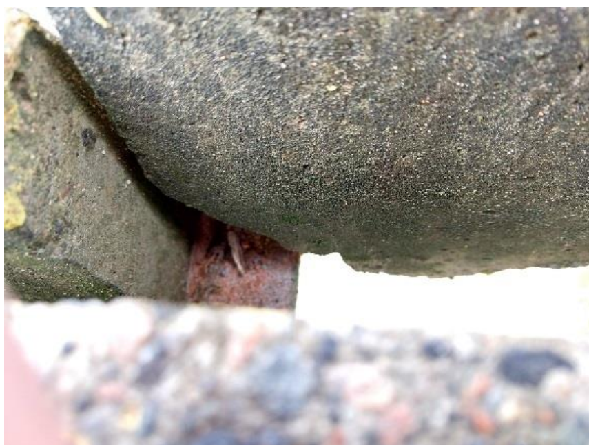
Figura 9 – Cisalhamento de dente de fixação de peça pré-moldada
