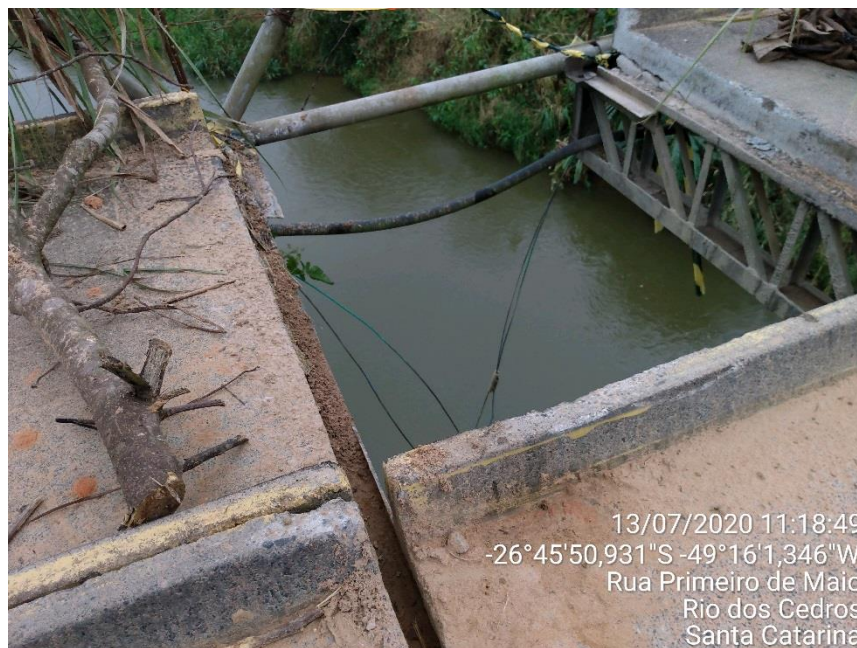
Figura 14 – Tabuleiro com peça pré-moldada faltante
