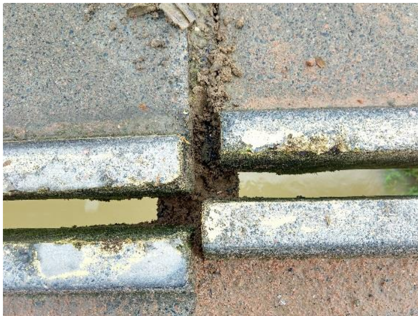
Figura 8 – Deslocamento transversal e longitudinal das peças pré-moldadas
