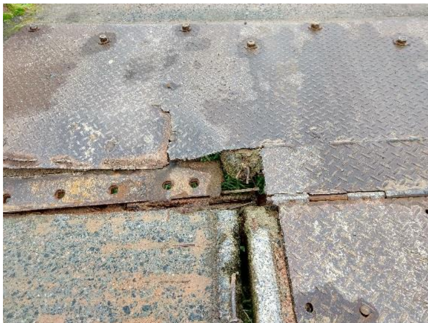
Figura 4 – Rachadura em rampa metálica
