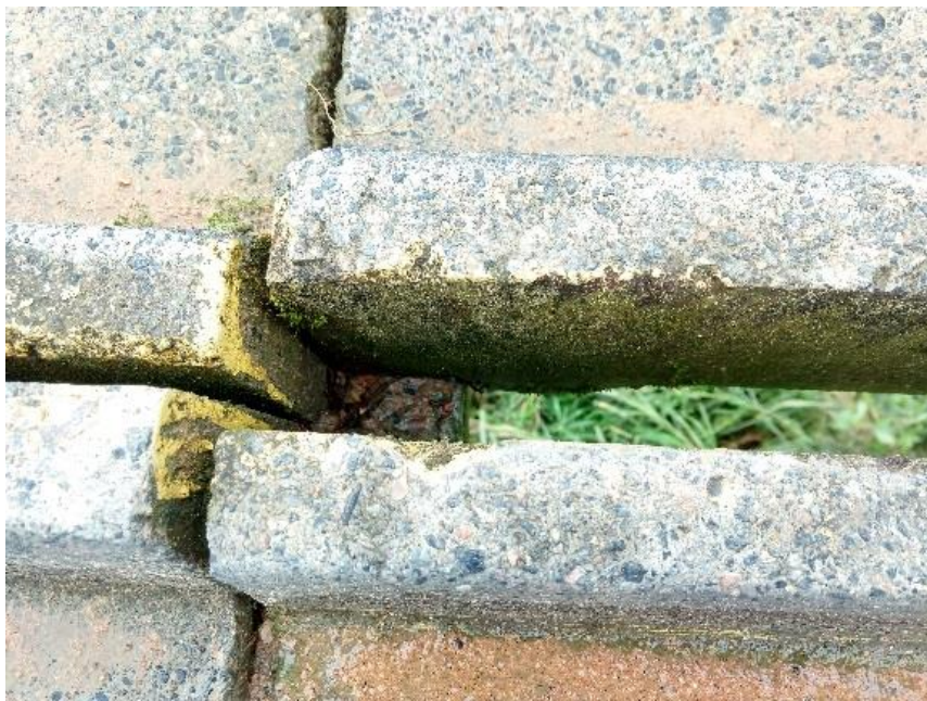
Figura 12 - Peça pré-moldada deslocada em função de detritos sobre a transversina
