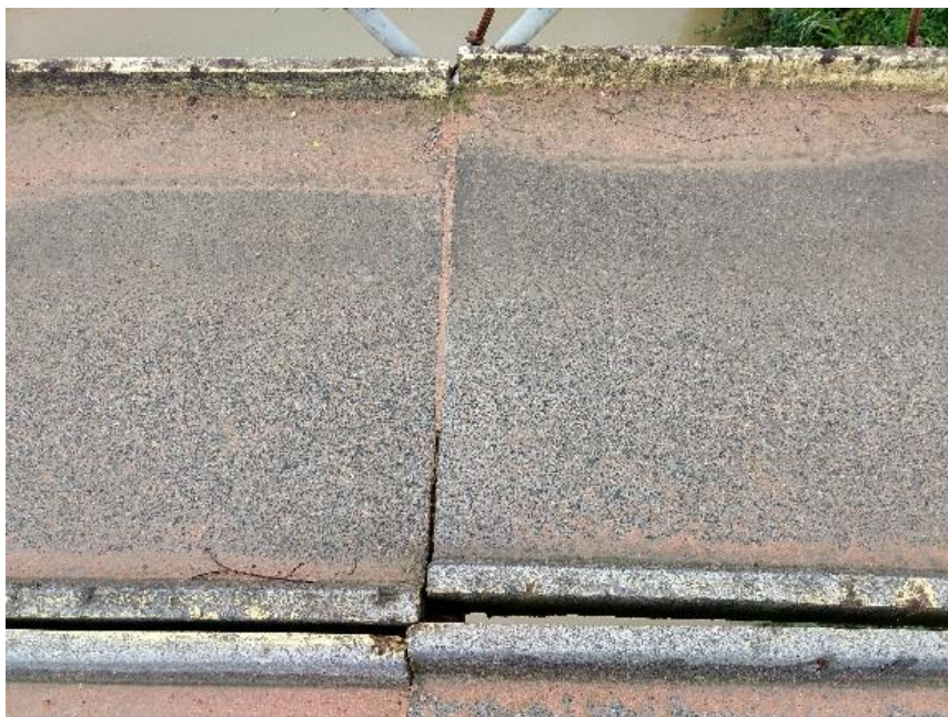
Figura 11 - Deslocamento transversal e longitudinal das peças pré-moldadas
