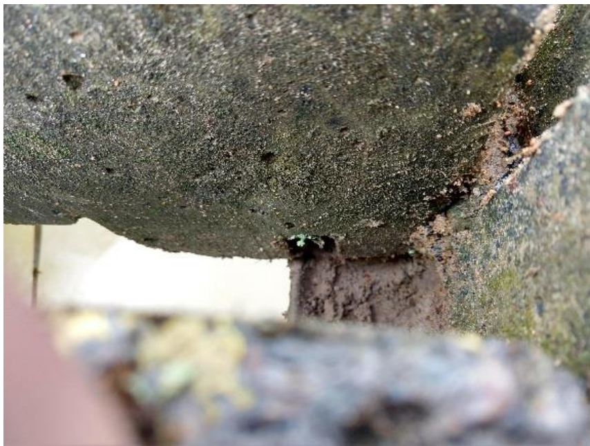
Figura 10 - Desalinhamento de dente de fixação de peça pré-moldada
