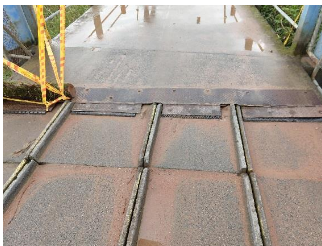
Figura 3 - Rampa metálica para concordância entre tabuleiro e laje da cabeceira
