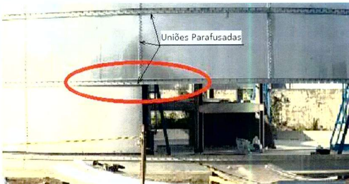
Detalhe da montagem das uniões parafusadas
