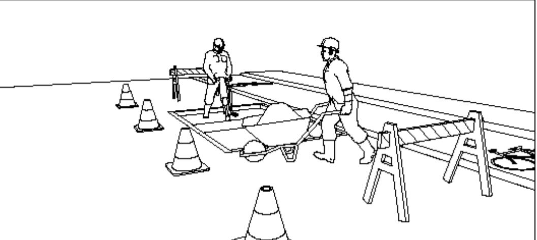
**4º RETIRADA DO MATERIAL DETERIORADO:** É necessário fazer a retirada dos materiais danificados decorrentes de intervenções realizadas pelo Município bem como a reutilização quando os mesmos apresentarem condições para o uso.
