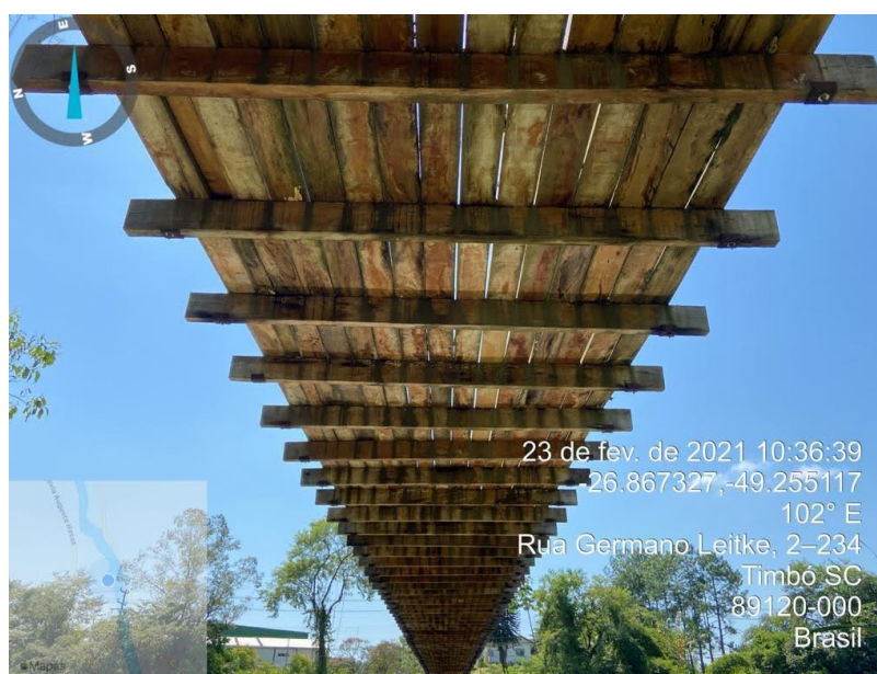
Figura 18 - Tabuleiro de madeira - vista inferior
