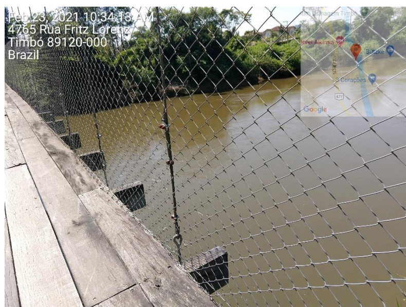
Figura 22 - Guarda-corpo em tela metálica - sem sinais de degradação
