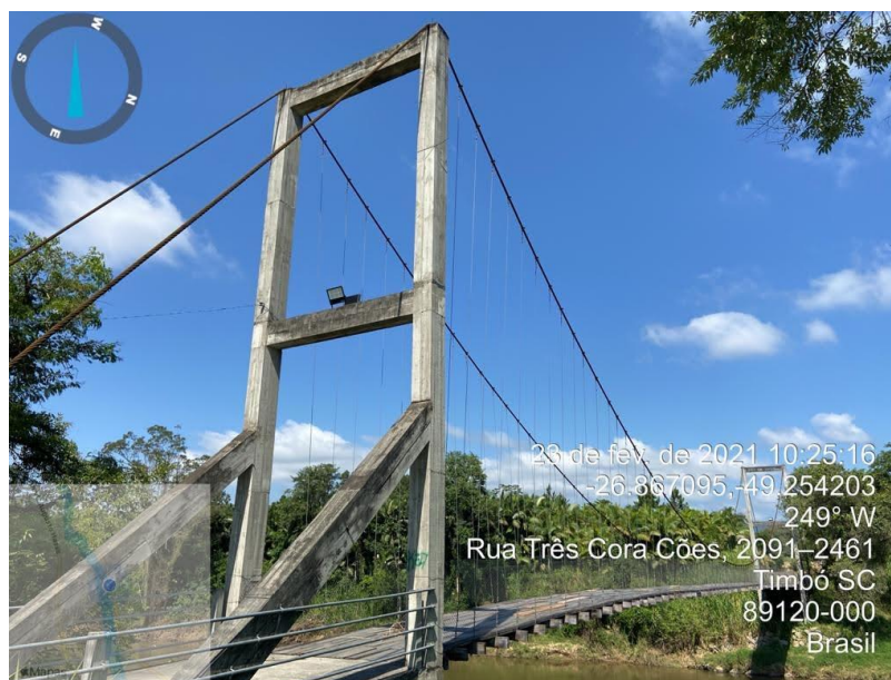
Figura 2 - Ponte Pênsil Sobre o Rio Benedito
