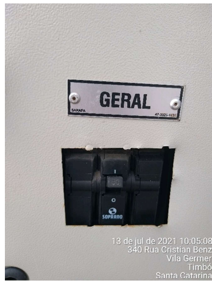
Figura 5 – Proteção Geral do Quadro Medidor Coletivo 50 A Trifásico
