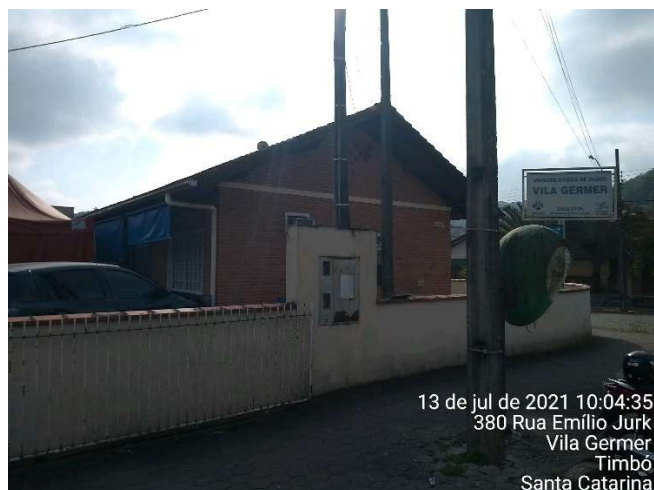
Figura 3 – Entrada de energia atual com quadro de medidor coletivo (2 medidores) em frente à edificação UBS Unidade de Saúde Vila Germer
