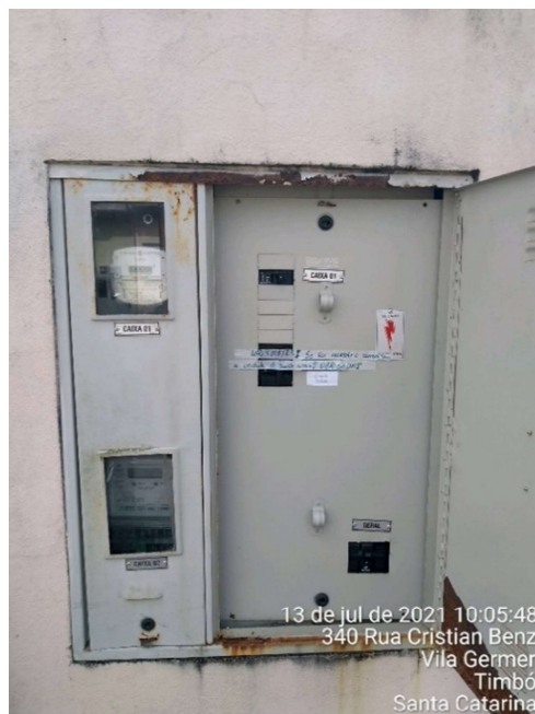
Figura 4 – Quadro Medidor Coletivo Existente
