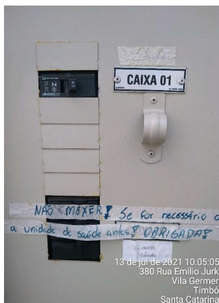
Figura 6 – Proteção Geral do Quadro Medidor Coletivo Caixa 01 – 50 A Monofásico UBS Vila Germer e Caixa 02 – 40 A Trifásico Unidade Pré-escolar Girassol Conforme UC cadastrados na Fatura da Celesc.
