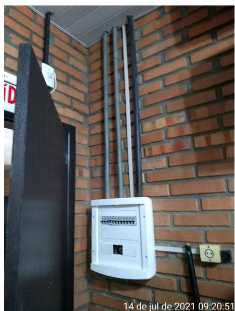
Figura 10 – Paineis Existentes Unidade Pré-Escolar Girassol (Cabos, eletrodutos e disjuntor deverão ser substituídos conforme projeto).
