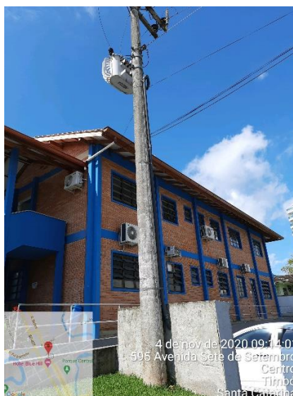
Figura 3 – Entrada de energia atual em frente à edificação P.M.T 1
