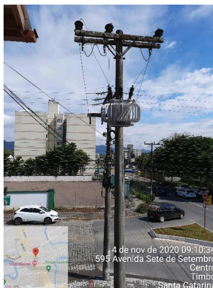
Figura 4 – Transformador atual de potência nominal 30 kVA
