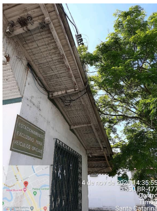
Figura 7 – Ligação de energia elétrica atual da edificação P.M.T 2
