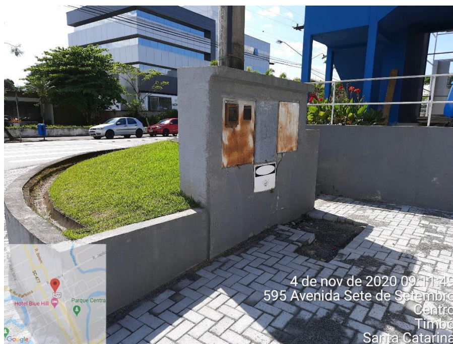
Figura 5 – Mureta da entrada de energia atual com disjuntor geral de 60 A
