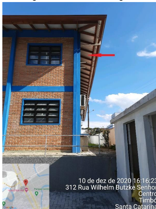
Figura 9 – Local da ancoragem do ramal de carga, nos fundos da edificação.
