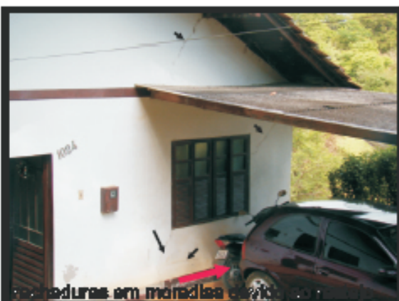
lançamento de águas servidas em talude
