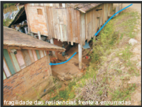
moradias na linha de drenagem
