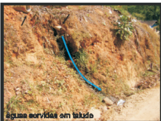
deslizamento de solo
