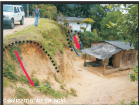
fragilidade das residências frente a enxurradas
