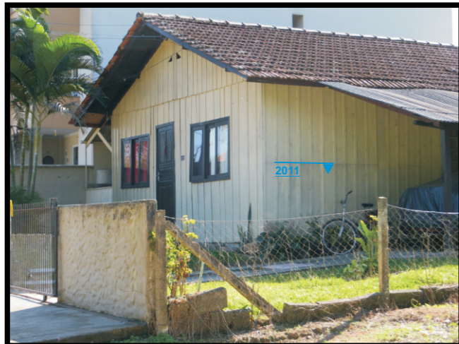
Nível d'água na inundação de 2011.
