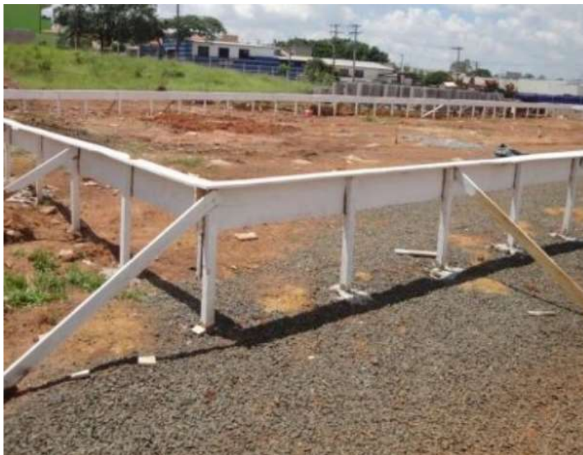
Figura 1 – Modelo de gabarito de tábuas corridas pontaletadas, com travamento.
