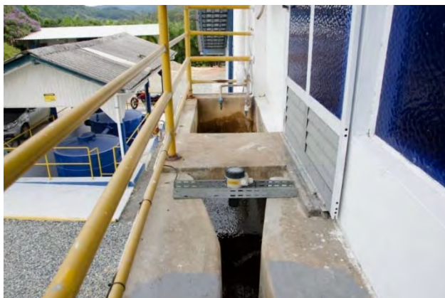
Figura 8 – Canal de entrada na ETA convencional
