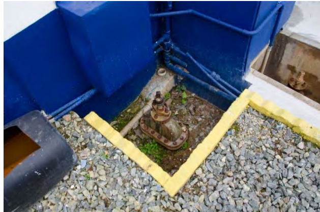
Figura 5 – Entrada de água bruta na ETA convencional
