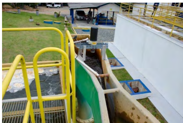
Figura 19 – Canal de entrada na ETA convencional
