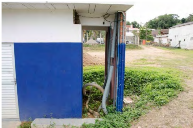
Figura 13 – Cabeamentos expostos na captação
