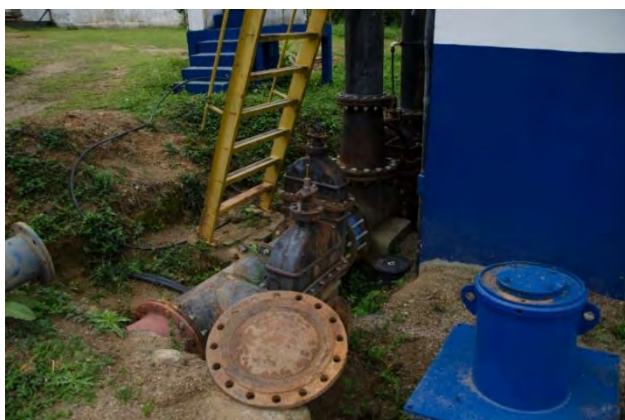
Figura 11 – Vista das tubulações de saída das bombas
