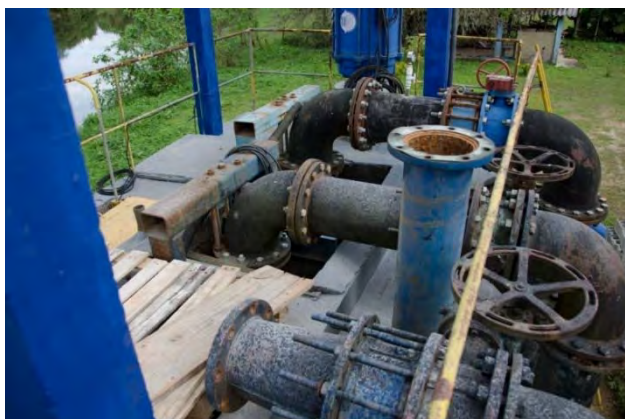
Figura 10 – Vista das tubulações de saída das bombas
