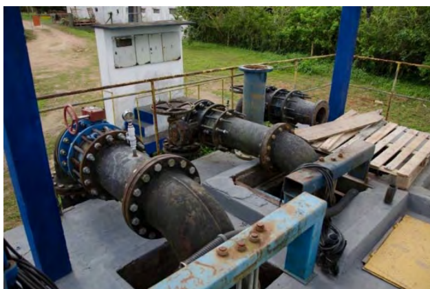
Figura 8 – Vista das tubulações de saída das bombas
