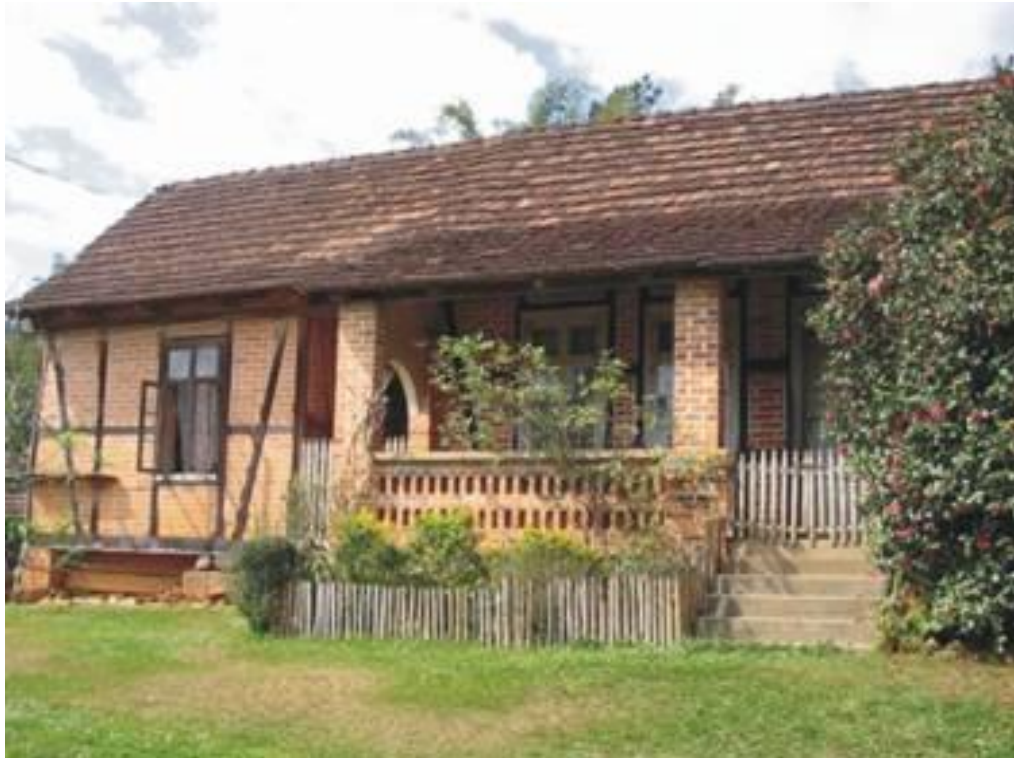
Figura 34: Casa Radoll. Propriedade da família Radoll, sob tombo do IPHAN. Karl Radoll, pai de Invalt Radoll, nasceu na casa em 1887. A construção da varanda data de 1929. Não está aberta a visitação.
